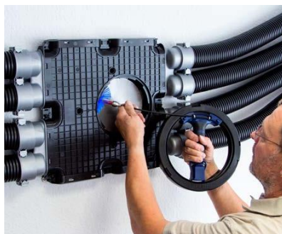
清洗分风箱和新风支管内壁
