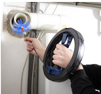
清洗高温换热管道夹层和内管内壁
